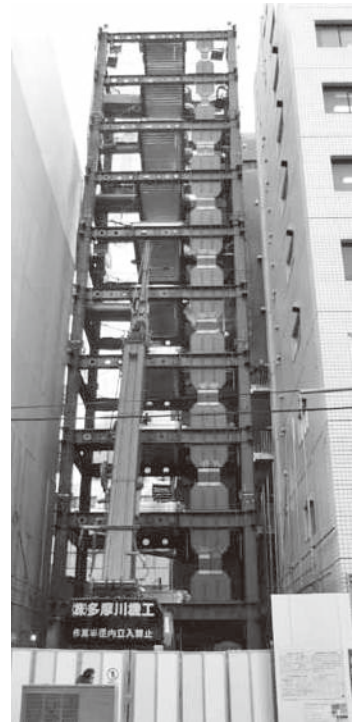
③主構造と制振装置
