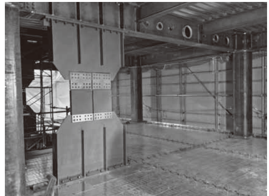
②ダンパーの設置
