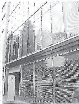
好調な稼働が続く虎ノ門の「エキスパートオフィス」
