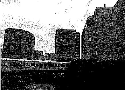
▲大型商業施設や本社ビルが立ち並ぶ
